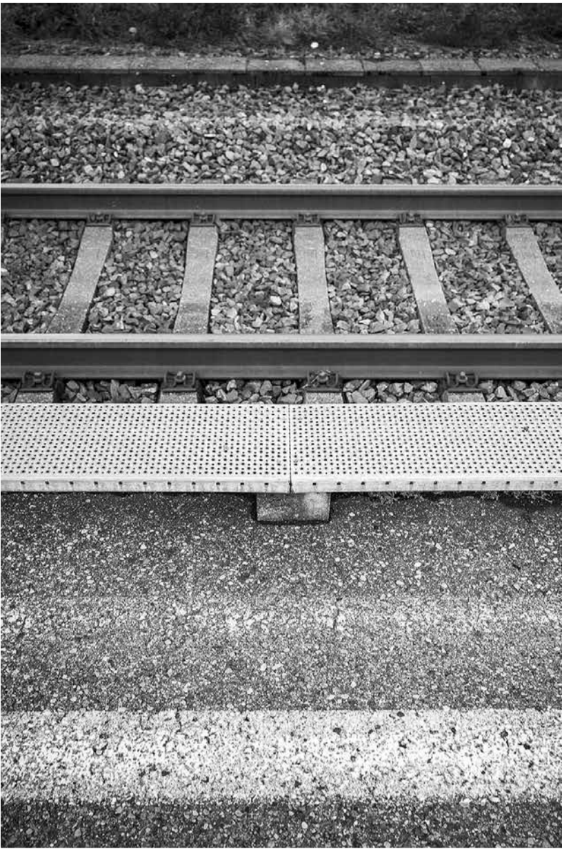
Stolperfalle: Provisorische Stufe am Bahnhof Siebnen SZ.
